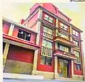
PRÉDIO da antiga Codesa
